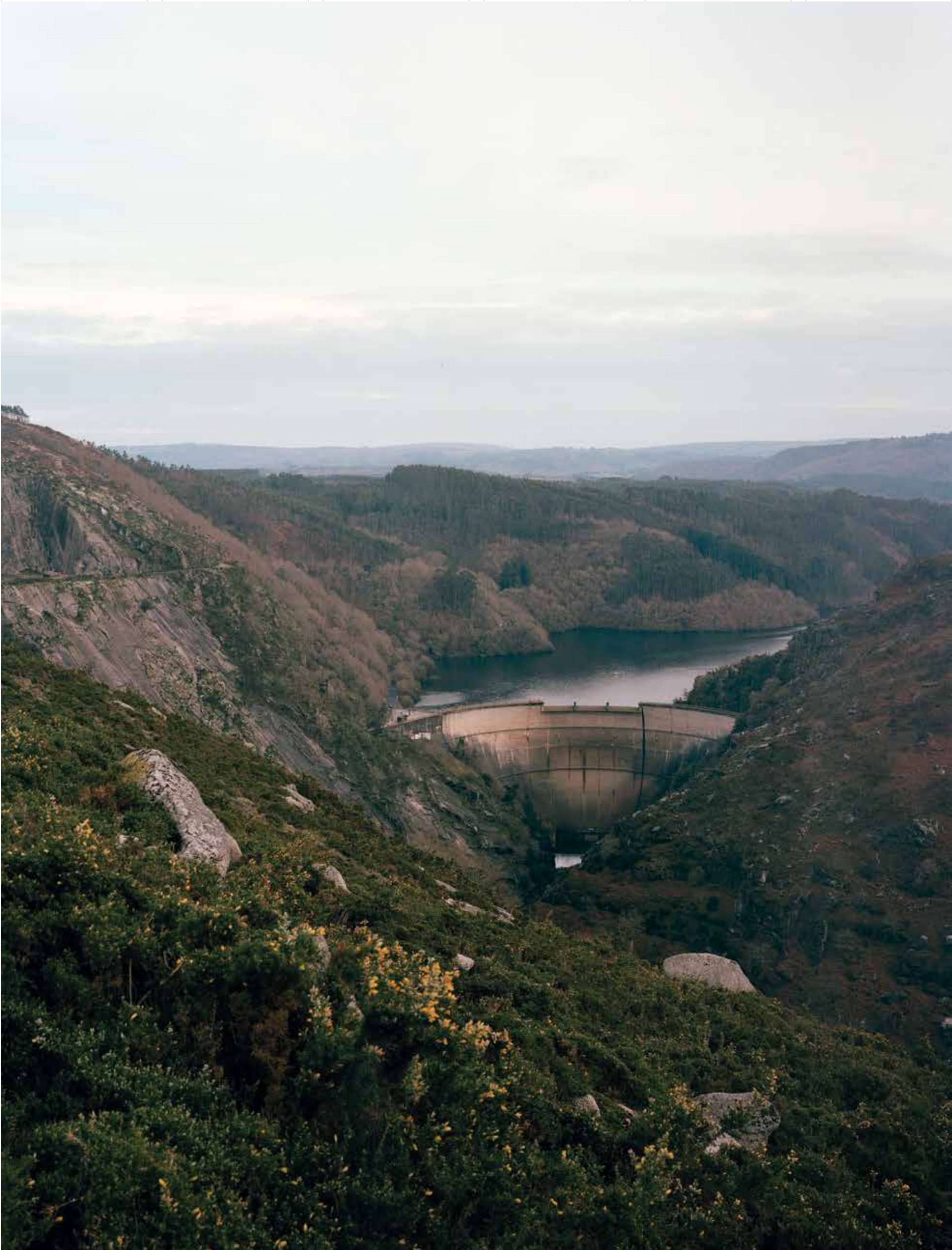
Embalse y presa del río Eume. Foto: Luis Díaz Díaz / Eume river reservoir and dam. Photo: Luis Díaz Díaz
