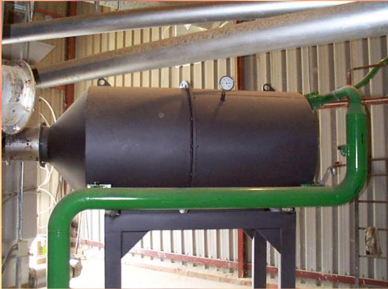
**Quemador ciclónico de polvo de lijado (100 kW)**
